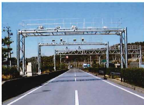
車両重量自動計測装置による計測
